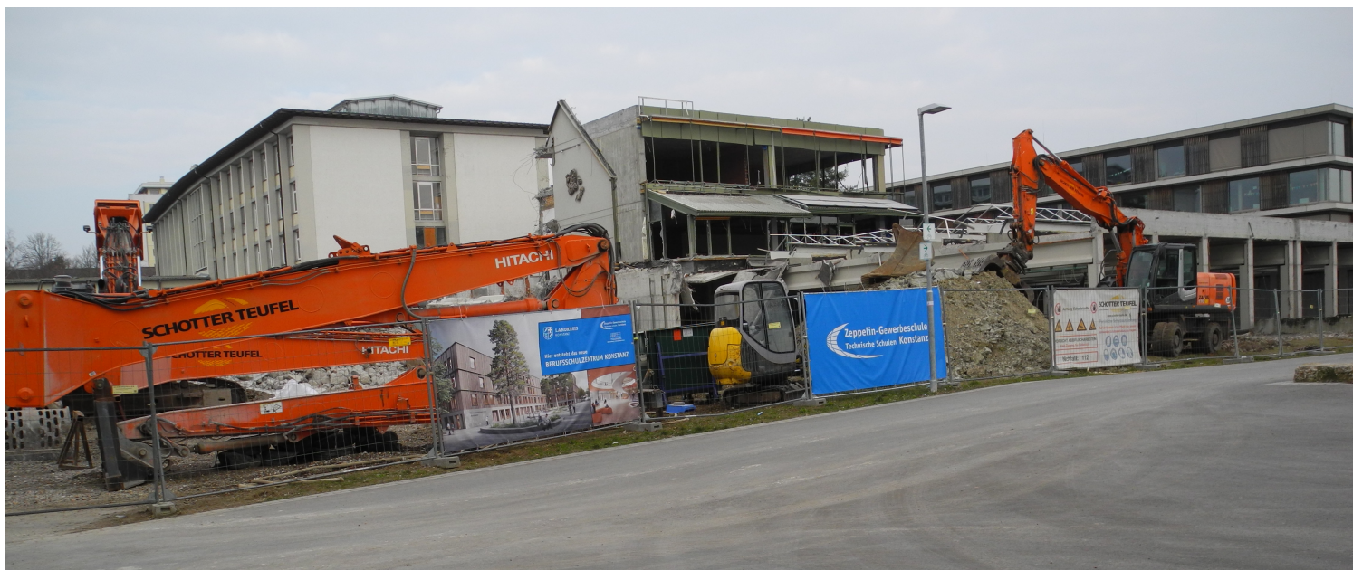
Abbruch Zeppelin-Gewerbeschule, Gebäudeteil A, 2023-03-03
