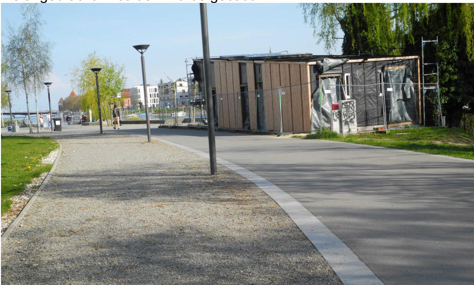
Schlimm, dass hier gebaut wird ...noch schlimmer, dass nicht gebaut wird!
